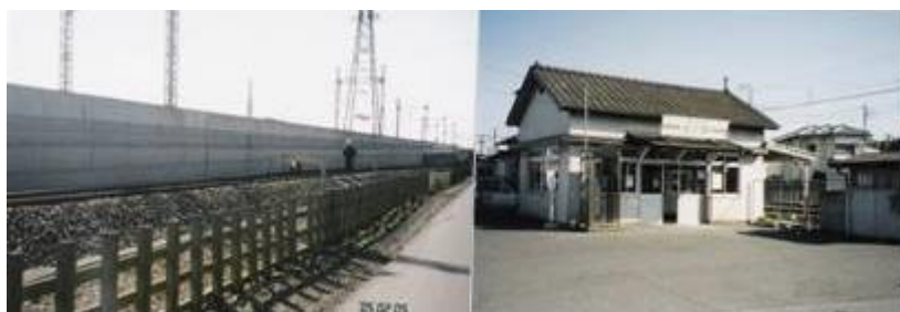
※レール撤去、葦川駅
